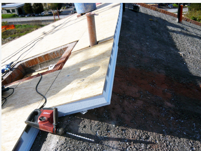
5. Cerchiatura per finestra da tetto
