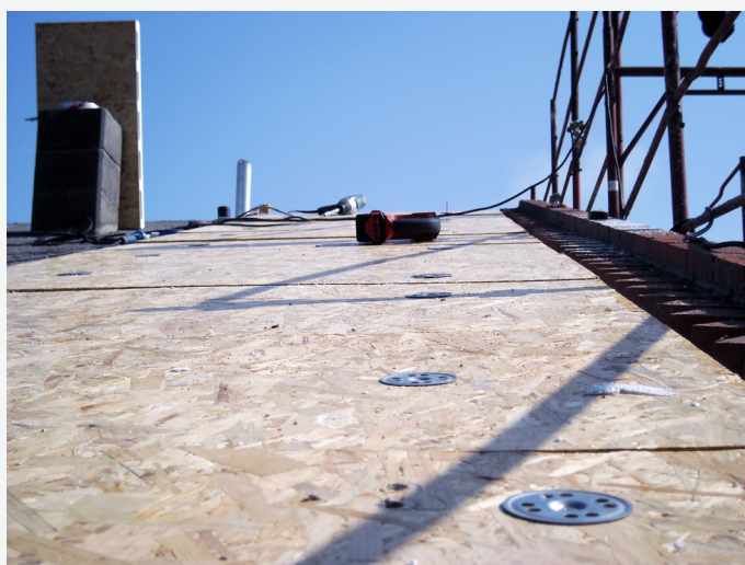
6. Tetto pronto per l'impermeabilizzazione
